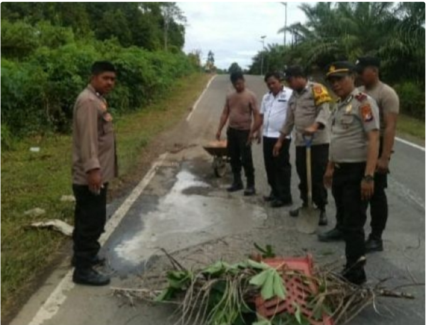
Kapolsek Pangale IPDA Syaiful meninjau langsung Jalannya penambalan jalan berlubang
